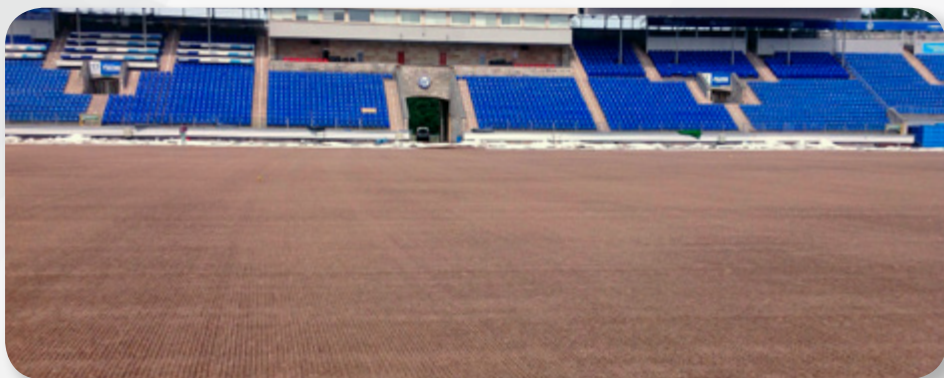
Укладка смеси Fibresand
