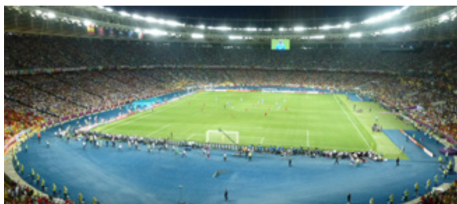
НСК Олимпийский, Киев, Реконструкция футбольного поля, поставка машинного оборудования www.nsc-olymp.com
